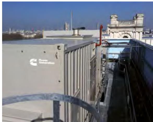
**A Cummins ESB instalou um gerador de emergência (standby) de gás natural no Institute of Civil Engineers em Londres.**
