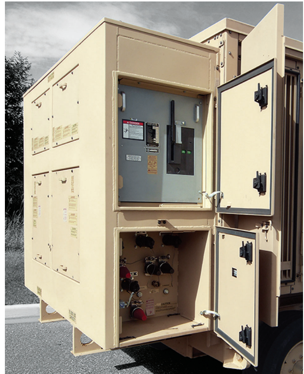
Load-connect switchgear
